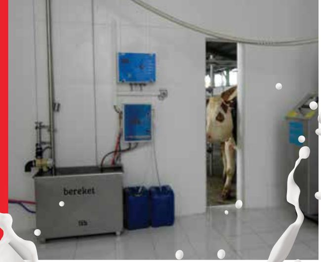
Otomatik deterjan ve asit dozajlamalı BRK 09 Otomatik Yıkama Makinası ayarlanabilir özellikleri sayesinde çiftliğinizin koşullarına en uygun yıkama döngülerini ve asitli yıkama sıklığını uygulamanıza olanak verir. Otomatik yıkamaya ilave olarak bağımsız durulama, bağımsız asit ve bağımsız deterjanla yıkama seçeneklerini sunar. Yıkama döngüsü enerji kesintilerinden etkilenmez.
